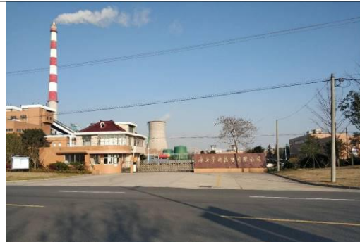
项目北侧海安华新热电有限公司
