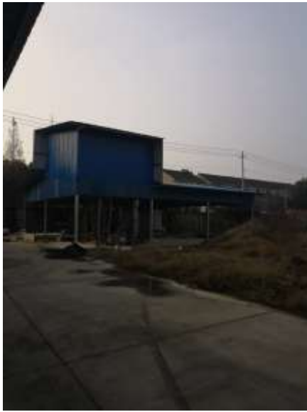
废水处理装置
