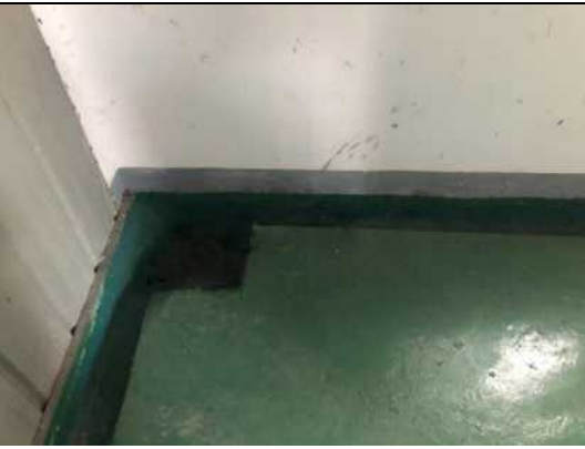
导流沟导流槽
